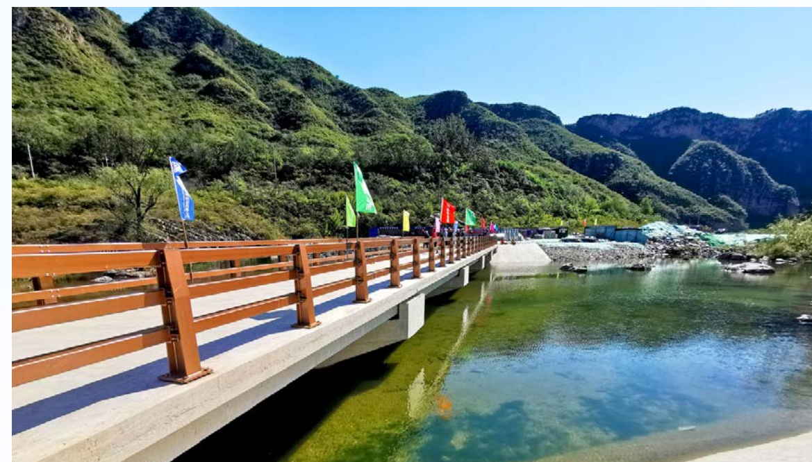
已竣工的山峡段 4# 漫水桥
