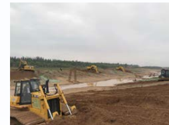
2021 年永定河全线通水应急疏通工程
