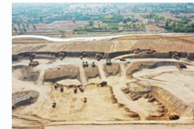
张家口桑干河综合整治工程
